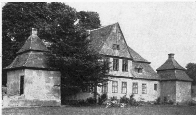
Fig. 25. Studzieniec, dwór 1. poł. w. XVIII. Widok od ogrodu (s. 19).
