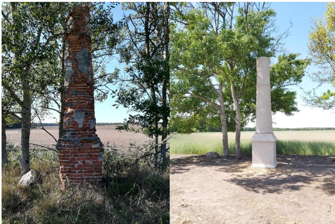
Włna kolumna zachodnia przed i po remoncie
