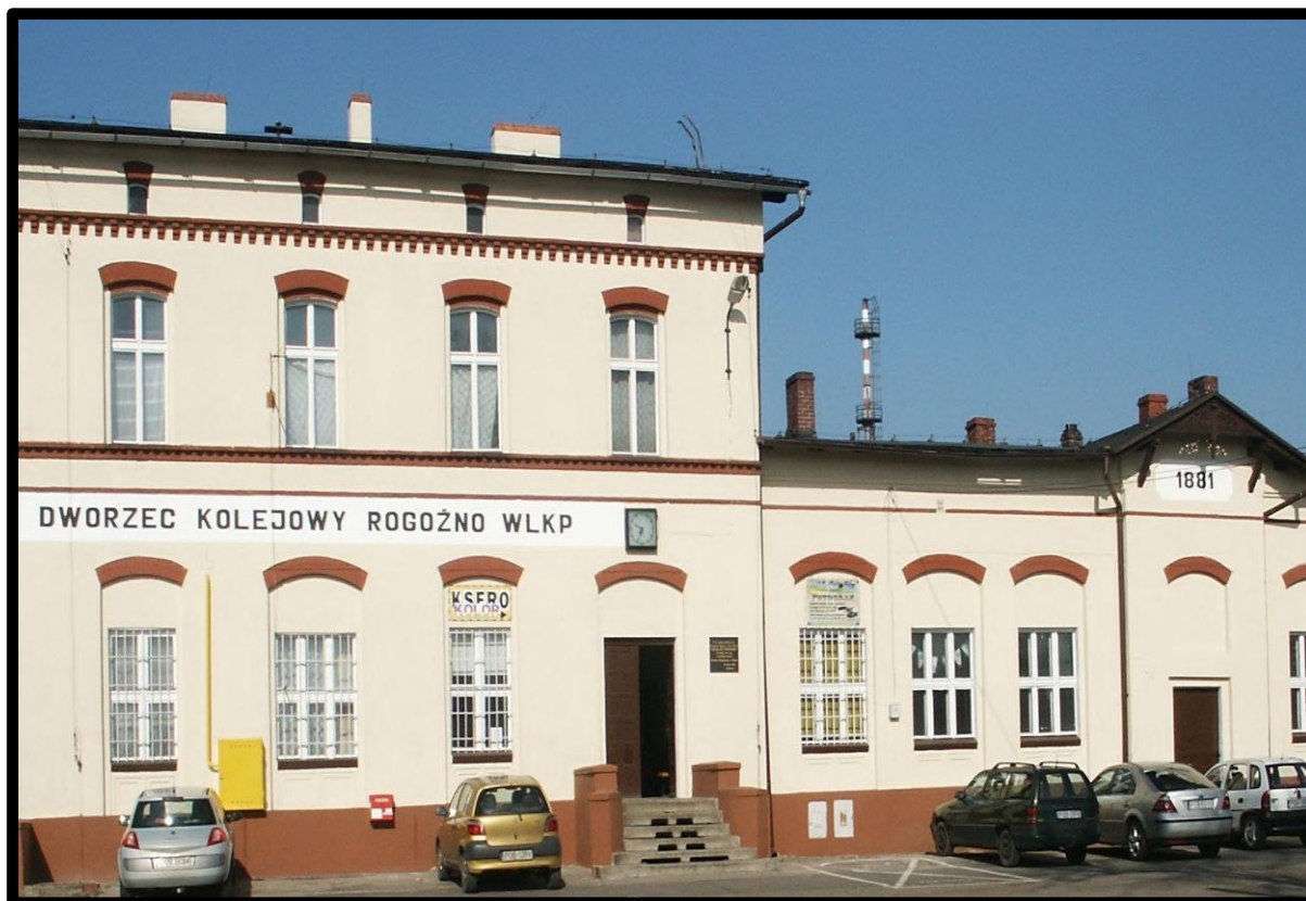
Budynek dworca kolejowego na którym umieszczono tablicę. Poniżej budynek dworca od strony peronów z czasów po Powstaniu Wielkopolskim
