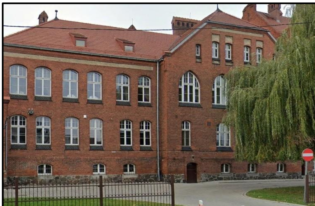
Tablica znajduje się na budynku od strony wschodniej.
