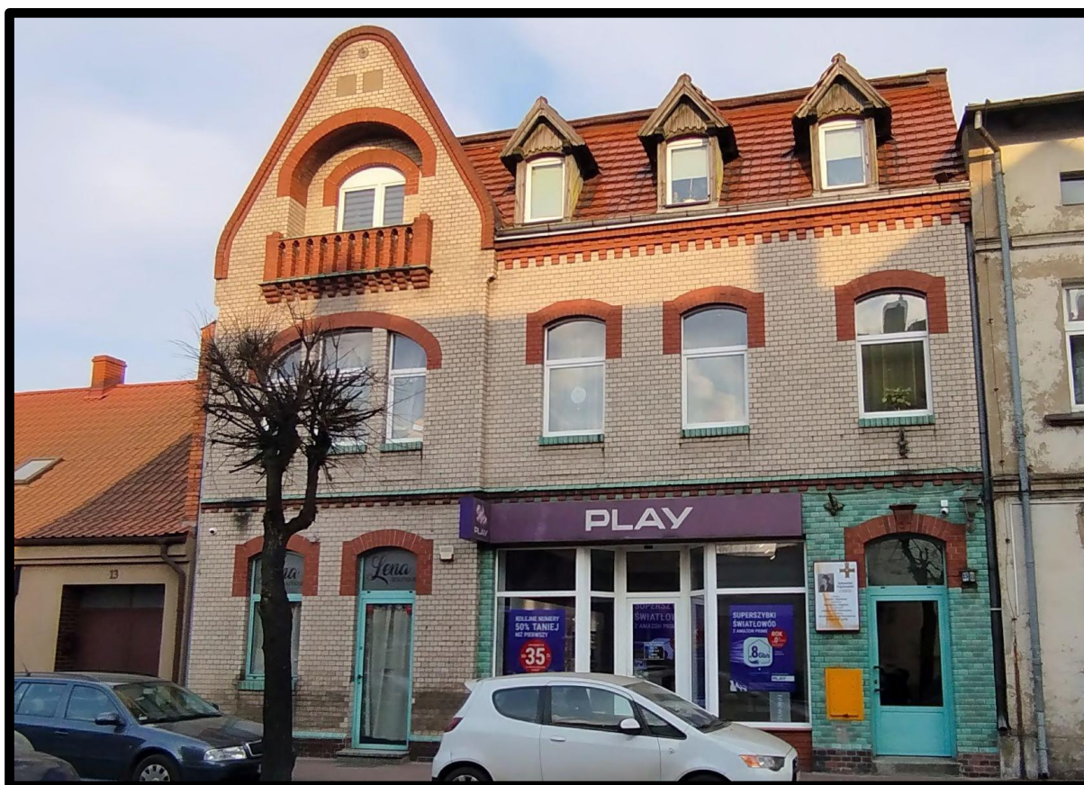
Dom Sylwestra Frąckowiaka przy ulicy Wielkiej Poznańskiej 15 W tym domu przez wiele lat na pierwszym piętrze mieszkał też dr Stanisław Waliszewski
